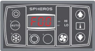
Falha no Display.
